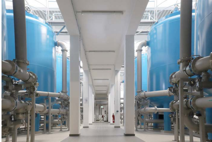
Die gewaltigen Filterkessel in der Maschinenhalle des Wasserwerks © WSE
