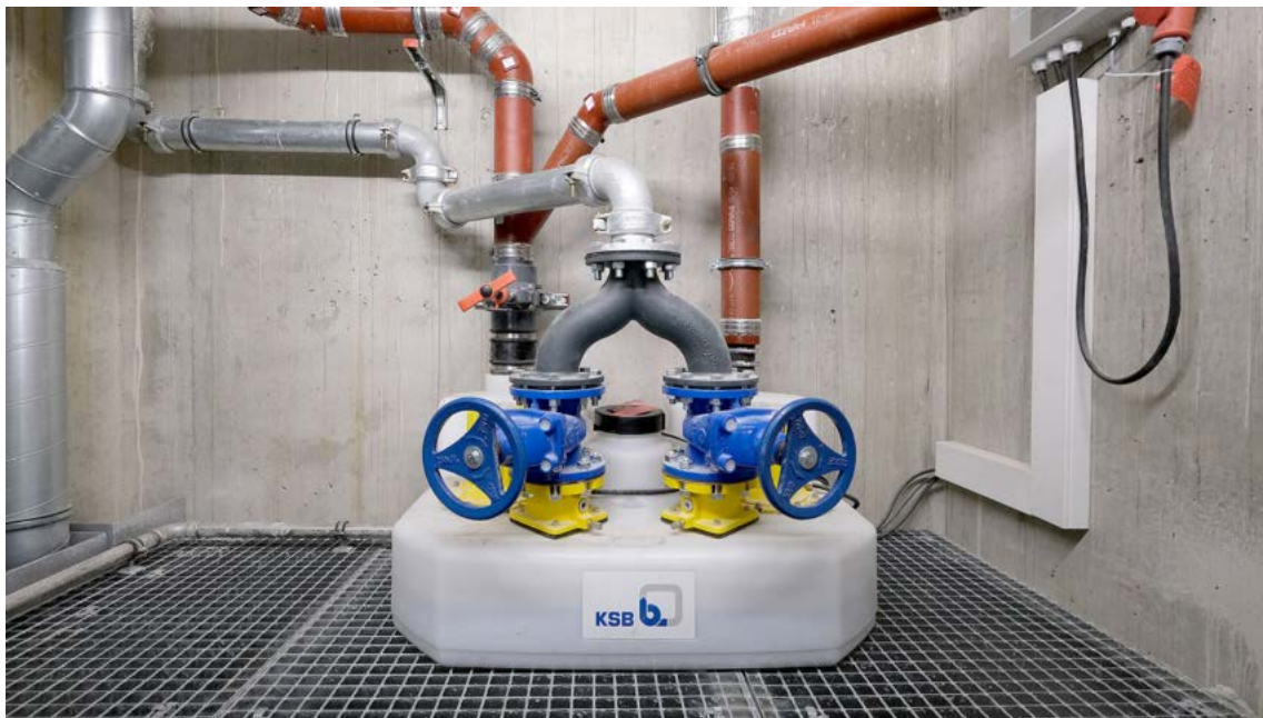
Eine von mehreren Compacta-Hebeanlagen
