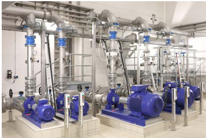
Verschiedene Etanorm-Pumpen-Modelle für Reinwasserförderung und Filterspülanlage © WSE
