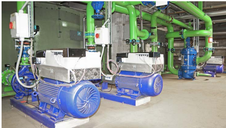
Etanorm-Pumpen und neue Verrohrung
