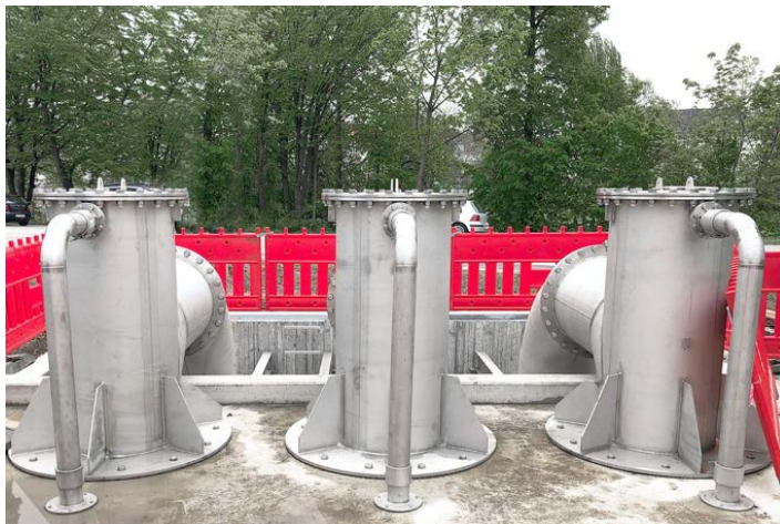
Wasserablaufbecken, davor Rohrschächte zu den Amacan-Pumpen
