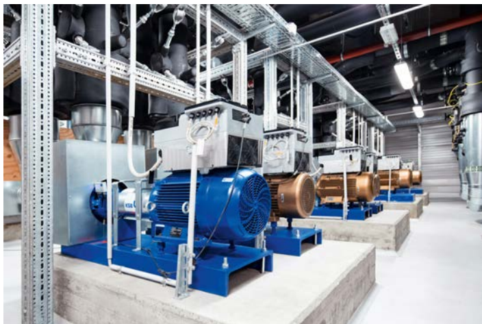
Etanorm-Pumpen mit PumpDrive2 in der Heizungszentrale
