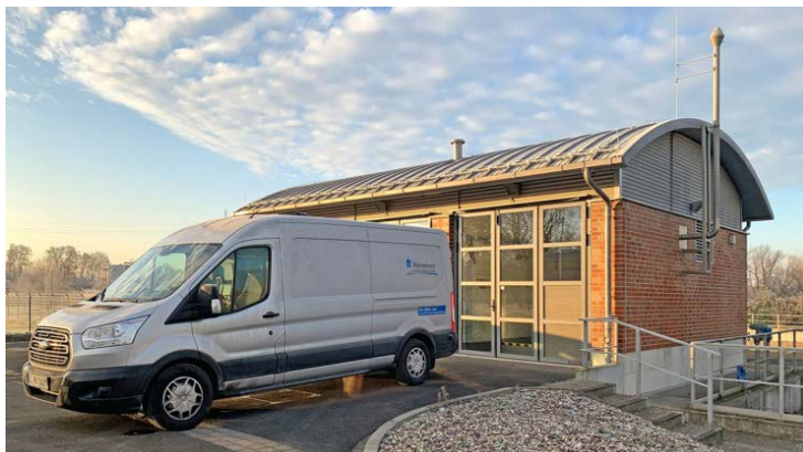
Eines von 125 Pumpwerken: Das Pumpwerk Fröndenberg
