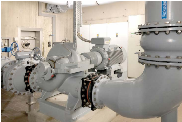
Eine der beiden Omega-Pumpen für die Rückspülung
