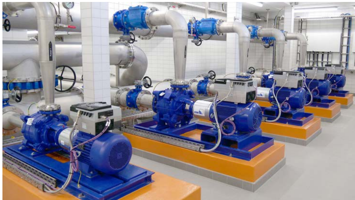
Multitec-Pumpen mit PumpDrive 2 zur Druckerhöhung
