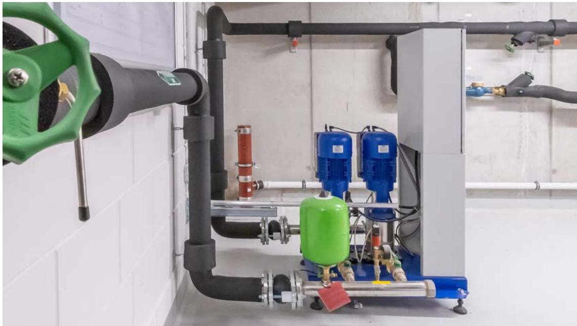
Zwei vertikale Hochdruckpumpen mit stufenloser Drehzahlregelung
