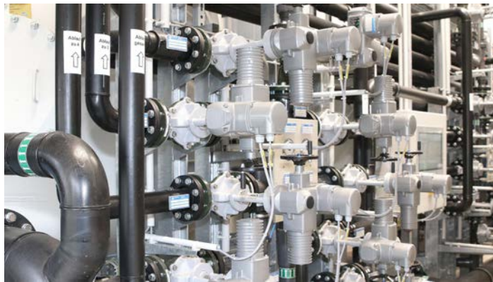
Ventilbatterie mit SISTO-20 mit ECTFE Beschichtung und AUMA Elektroantrieben
