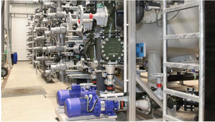
Ventilbatterien mit SISTO-20 Membranventilen, SISTO-RSK Rückschlagklappen und Etabloc-Pumpen
