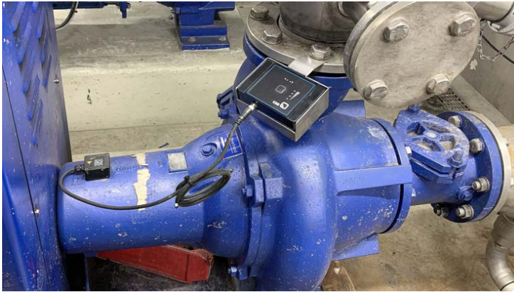
KSB Guard auf einer Sewatec-Pumpe
