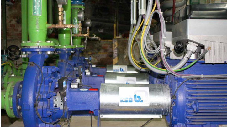
Etanorm-Pumpen mit aufgeklebtem KSB Guard
