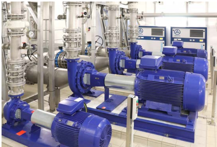
Verschiedene Etanorm-Pumpen-Modelle für Reinwasserförderung und Filterspülanlage © WSE
