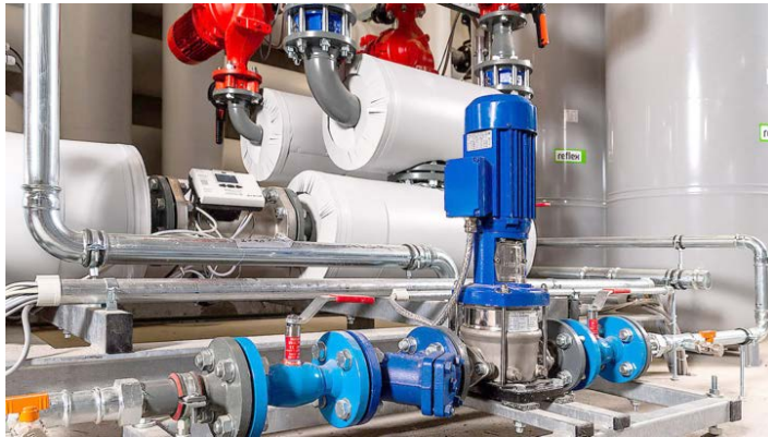
Movietec-Pumpe und BOA-S Schmutzfänger im Einsatz
