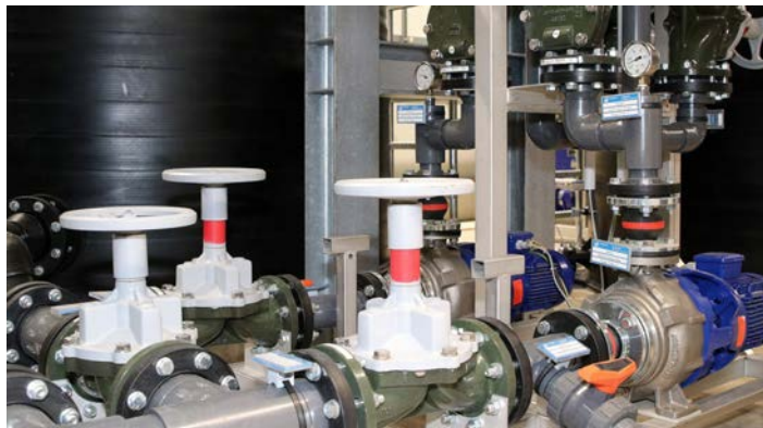
SISTO-20 mit ECTFE Beschichtung, SISTO-RSK und KWP-F-Pumpen
