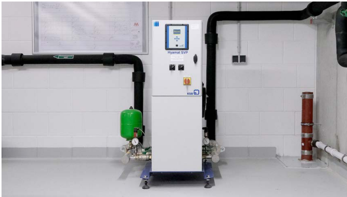
Hyamat SVP Druckerhöhungsanlage im Einsatz
