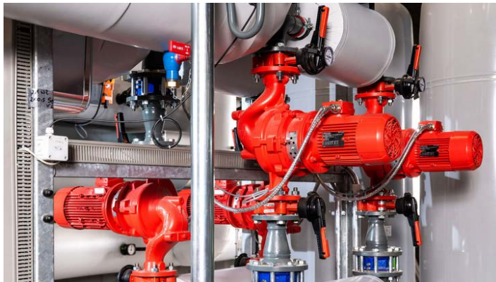
Etaline-Pumpen, BOA-X Absperrklappen und Serie 2000 Rückschlagklappen im Einsatz
