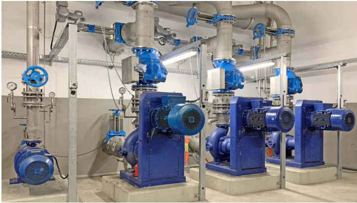
Sewatec-Pumpen in der Maschinenhalle des Pumpwerks Fröndenberg
