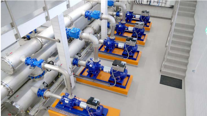
Maschinenhalle des Wasserwerks Groß Schönwalde
